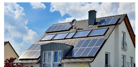
▲ Sonnenergie (Warmwasser) kombiniert mit Photovoltaik
