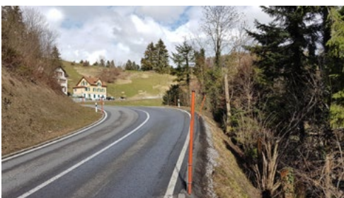
▲ Das fehlende Trottoir wird talseitig ergänzt.
