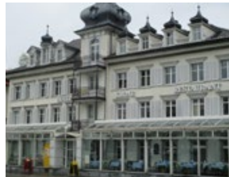
▲ Stolzer Kreml von Heiden: In den kommenden Monaten wird das Kulturobjekt „Krone“ umgebaut und einer neuen Nutzung zugeführt.
