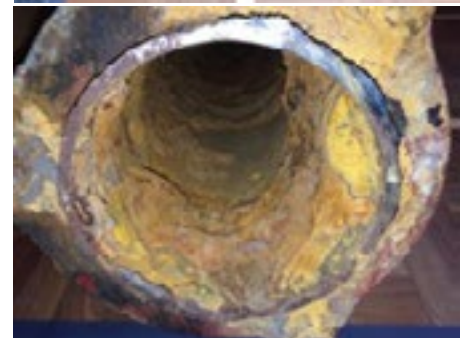
▲ Beispiel: Dieses Leitungsstück wurde im Leitungsnetz Trogen ausgebaut.
