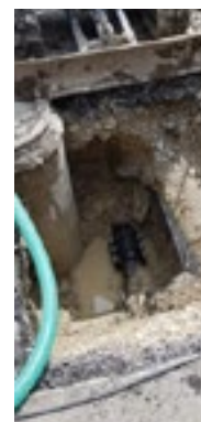
▲ Erschwerte Reparatur in einem Trottoir
