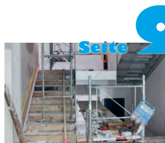
Umbau altes Schulhaus
