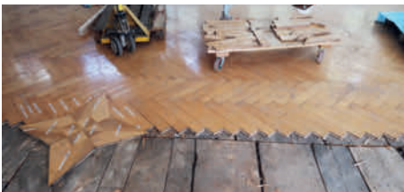
▲ Der versiegelte Parkett wird herausgenommen und für den Wiedereinbau nummeriert.
