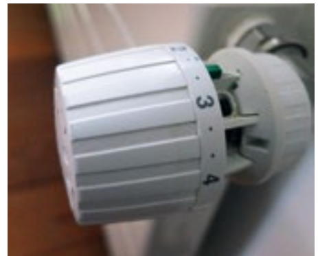
▲ Thermostatventile ermöglichen die Temperatur den Bedürfnissen entsprechen in verschiedenen Räumen unterschiedlich zu regeln
