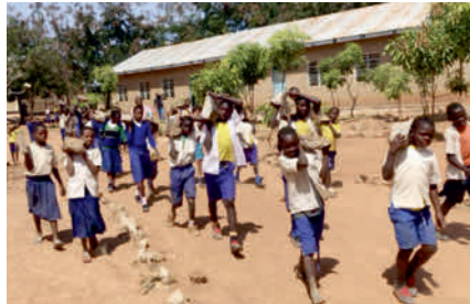
▲ Alle packen mit an: Steineschleppen für das Fundament der Schulküche
