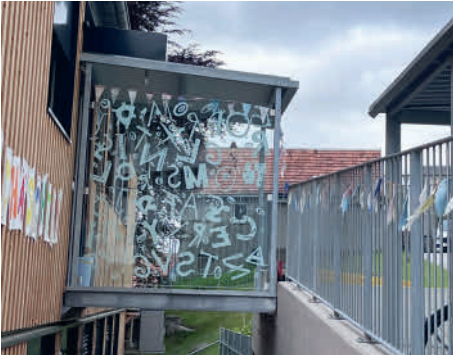
Kreative Umsetzung einer Vogelschutzmarkierung beim neuen Primarschulhaus in Trogen
