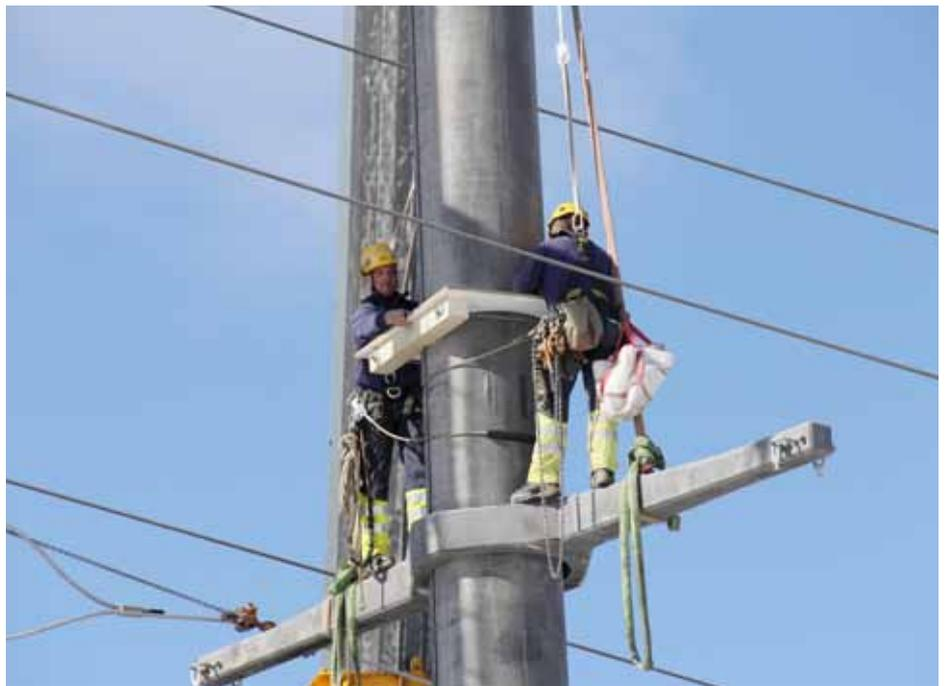
eines neuen Betonmasts umgangen werden. Im Vorfeld der Anlieferung mussten das Einspannfundament gebaut und die nötigen Sicherheitsvorkehrungen getroffen werden.
